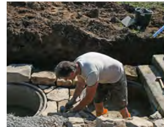
Hier wird gerade ein Feldbrunnen gebaut.
