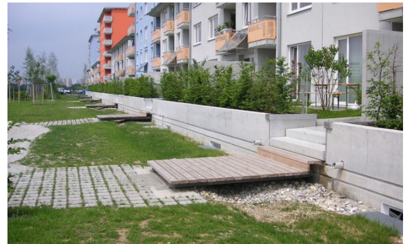
Abb: Versickerungsmulde und Ableitungssystem © Andreas Rockinger
