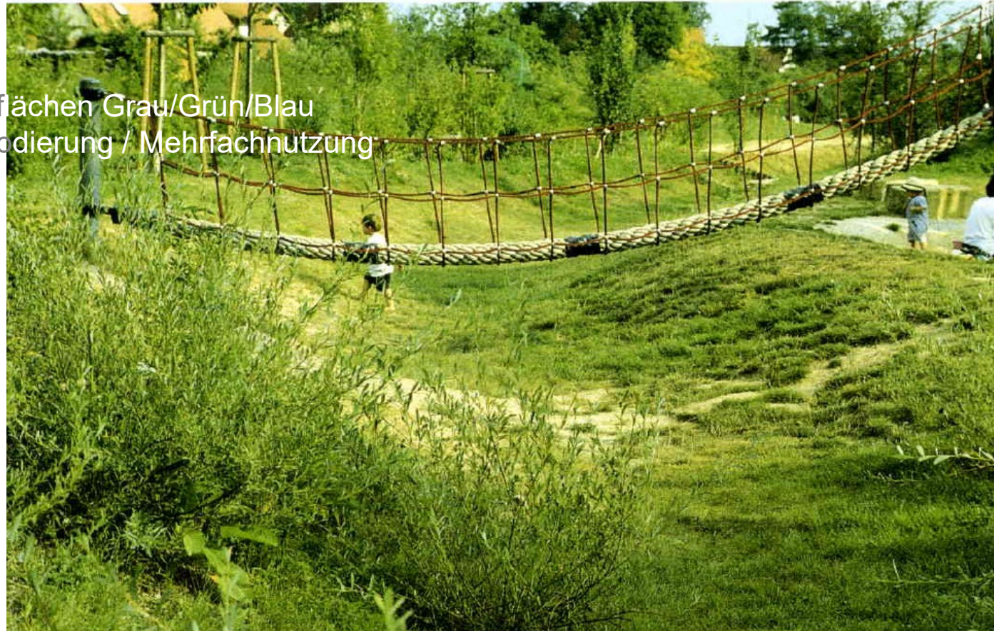
Abb: Versickerungsmulde in einem Spielplatz, Oberste Baubehörde-ArbeitsblätterBauleitplanungNr15-S14-Naturnaher Umgang Regenwasser
