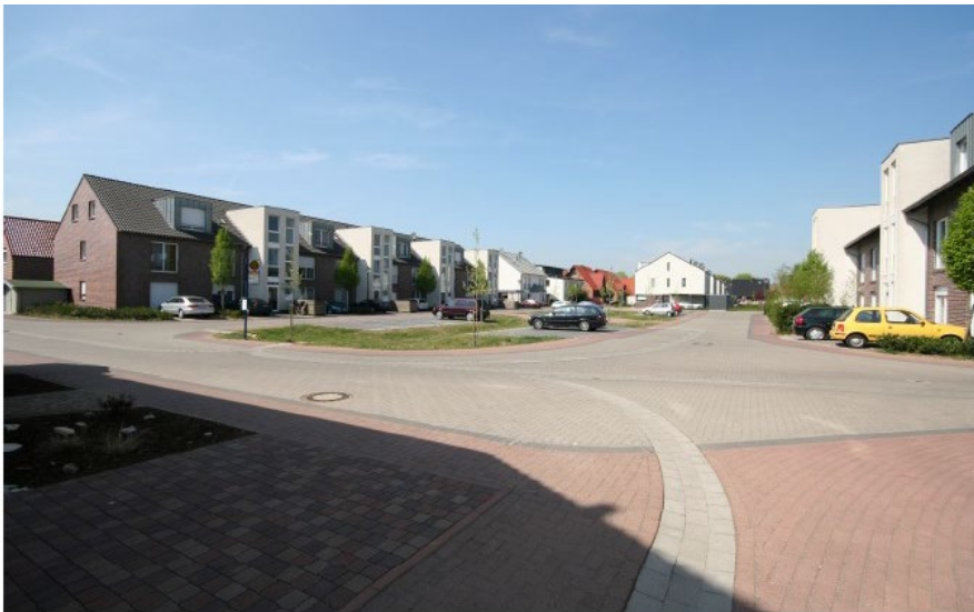
Abbildung 8: Dezentrale Regenwasserbewirtschaftung – offene Ableitung über Rinnen, Anordnung der Versickerungsmulden in Verkehrsgrün
