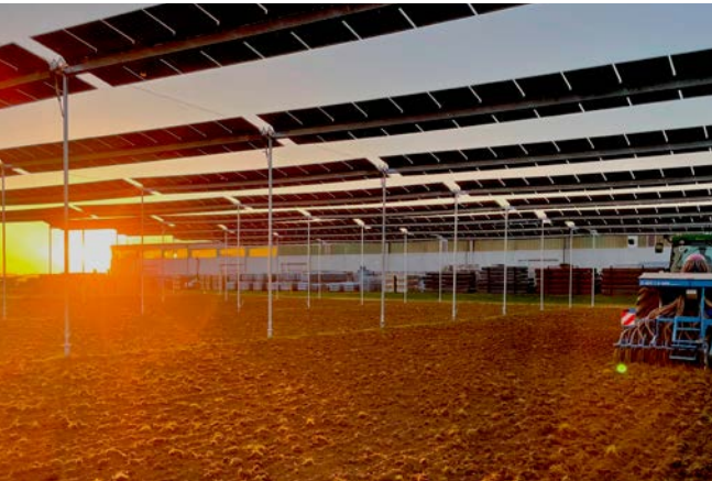
▭ Bild 5: Hoch aufgeständertes System der Firma Krinner mit einachsiger Nachführung der Module (Foto: Krinner)
