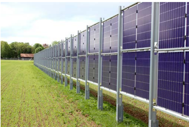
▭ Bild 8: Bodennahes statisches System der bayerischen Staatsgüter in Grub zu Forschungszwecken, System von Next2Sun
