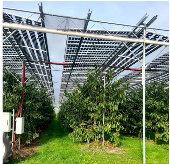
Bild 1: Verschiedene semi-transparente Module über Kirschen in Ensrijk (NL); Anlage der BayWa r.e. (Foto: Jim-Lukas Münch)
