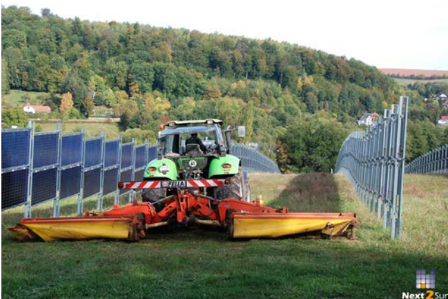
▭ Bild 2: Bodennahe System der Firma Next2Sun mit bifazialen Modulen (Foto: Next2Sun)
