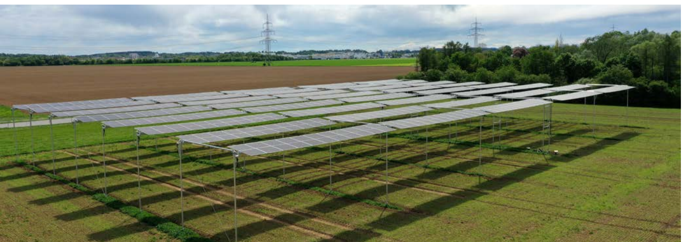
▭ Bild 6: Hohes einachsig nachgeführtes System der bayerischen Staatsgüter in Grub zu Forschungszwecken, System von Krinner (Foto: Malte Stöppler, TFZ)
