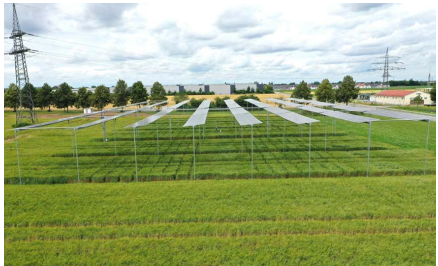
□ Bild 2: Hoch aufgeständerte nachgeführte Agri-PV-Anlage mit Versuchspartellen und einer lichten Höhe von circa 4,5 Meter sowie einer Bewirtschaftungsbreite von 12 Meter; Bewirtschaftungsrichtung für übliche Landtechnik von links nach rechts, mit Parzellenerntetechnik von vorne nach hinten
