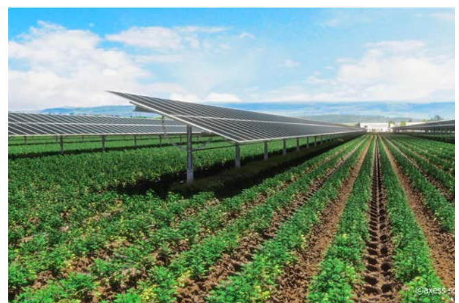
▭ Bild 4: Bodennahe Trackingsystem mit Kartoffeln der Firma Axess Solar (Foto: Axess Solar GmbH)
