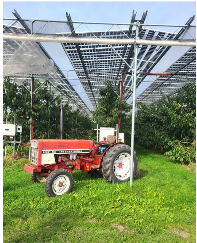
▣ Bild 1: Hochaufgeständerte Anlage über Kirschen der Baywa r.e. in Enspeijk (Foto: Jim-Lukas Münch)
