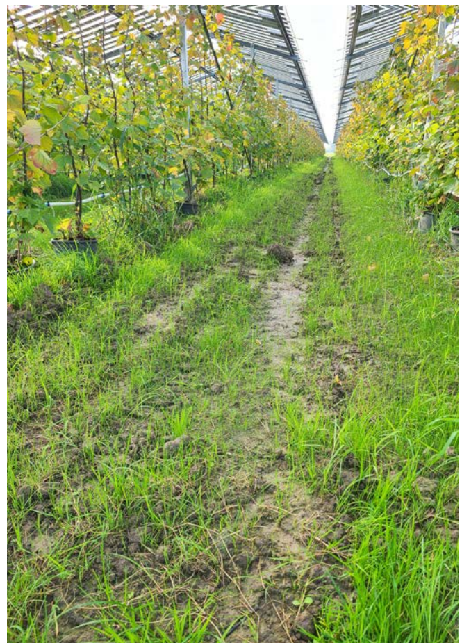
▣ Bild 5: Schäden durch Bodenverdichtung bei Bau und Abtropfkante der Module (Foto: Jim-Lukas Münch)
